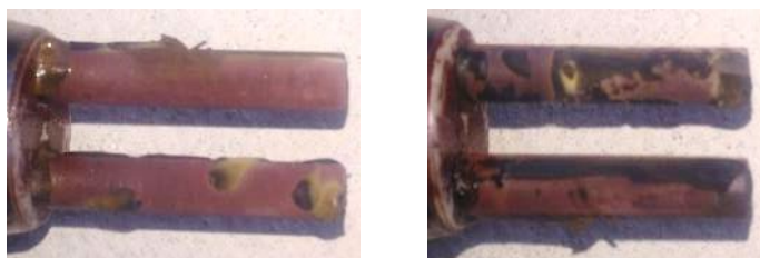
Рисунок 7.40 – Фото електродів датчиків корозії на лінії підживлення, вкритих шаром металічної міді.
