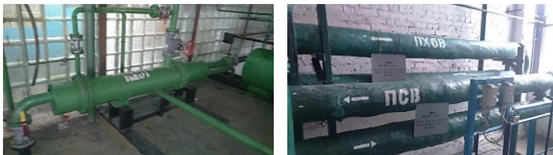
Рисунок 7.24 – Теплообмінники водопідготовки котельні РК «Молодь»
