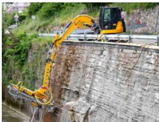
Рисунок 5.6 – Бурові установки для влаштування ґрунтових анкерів
