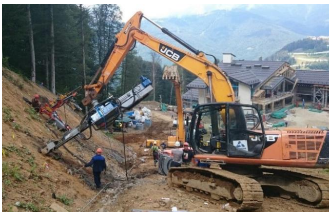
Рисунок 5.6 – Бурові установки для влаштування ґрунтових анкерів
