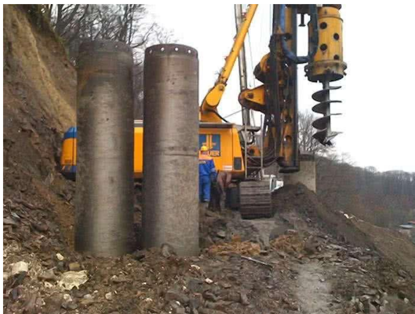
Рисунок 5.1 – Робочий майданчик для влаштування буронабивної палі на укосі із застосування обсадної труби
