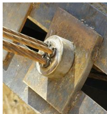
Рисунок 5.8 – Закріплення ґрунтового анкера в свердловині
