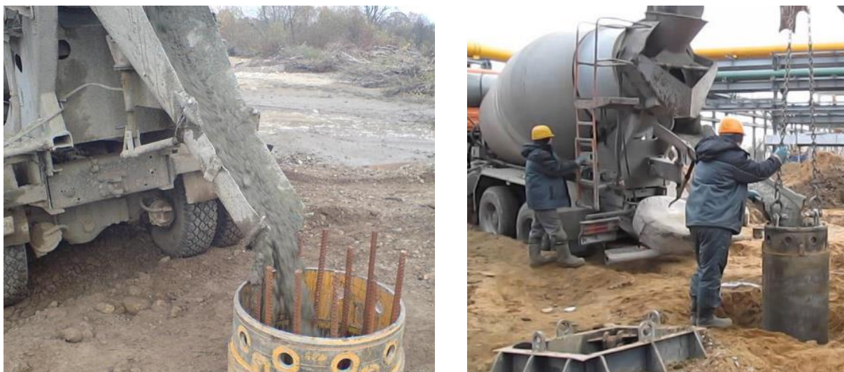
Рисунок 5.3 – Заповнення бетоном свердловини з арматурним каркасом
