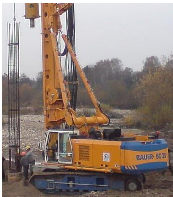
Рисунок 5.2 – Занурення у свердловину просторового арматурного каркасу
