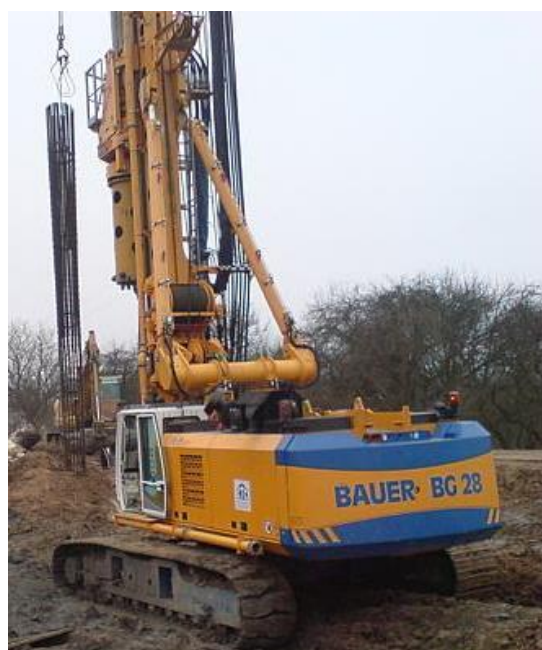
Рисунок 5.2 – Занурення у свердловину просторового арматурного каркасу
