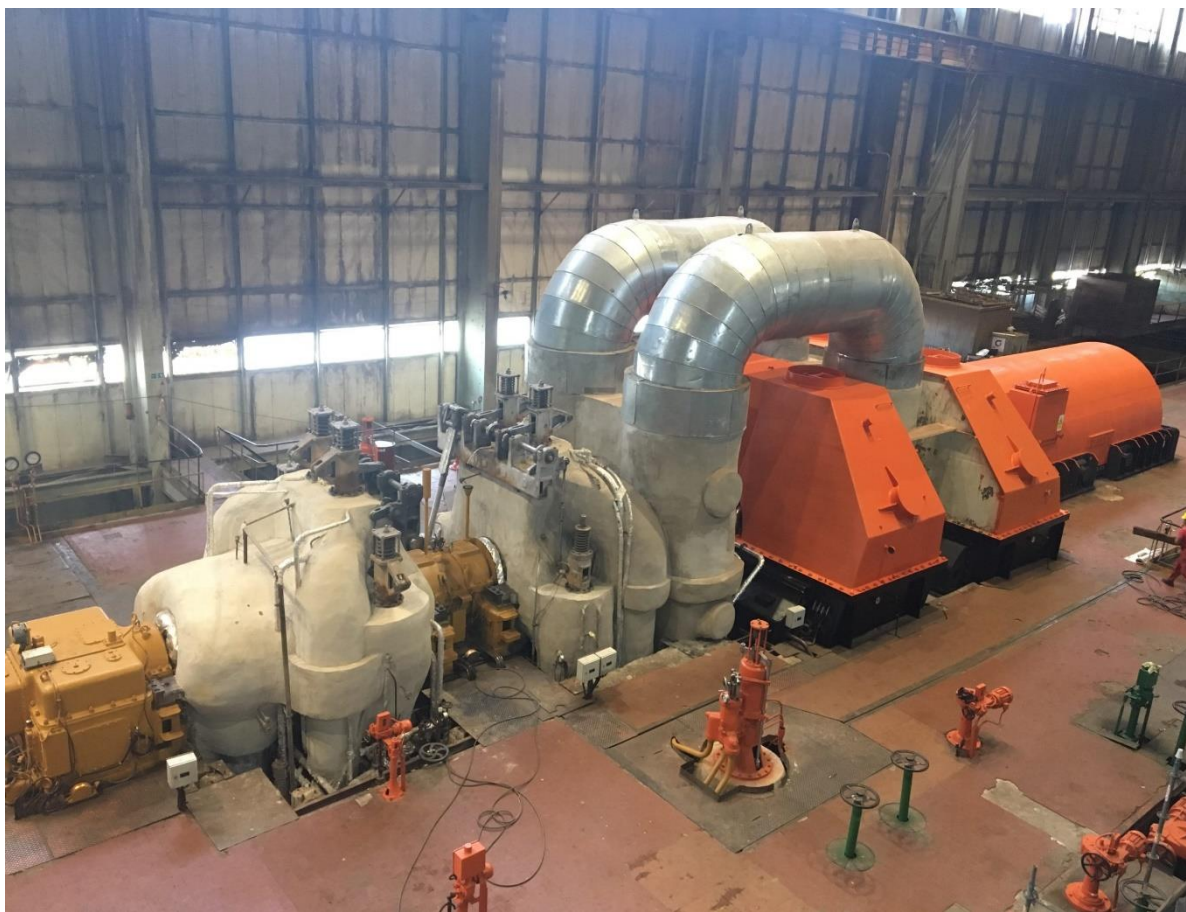
Рис. 2.1. Загальний вигляд турбіни К-200-130 [70]
