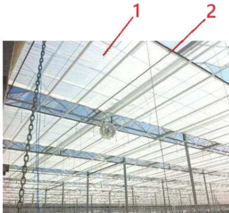
Рис.1.1. Система зашторювання: 1- шторний екран; 2 – механізм зашторювання
