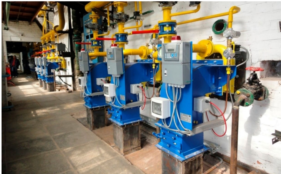
Рис. 1.16 Котел КВГ-6,5 модернізований з використанням струменево-нишевих пальникових пристроїв.
